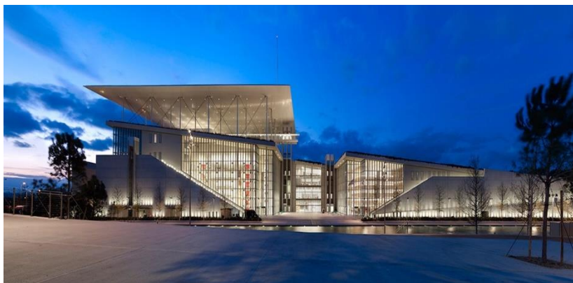
Εικ.4. Αποψη του κτιρίου της Εθνικής Λυρικής Σκηνής στο ΚΠΙΣΝ ( https://www.nationalopera.gr/kpisen )
