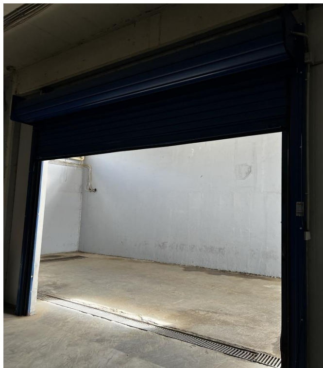
Εικόνα 20: Ρολλό υπογείου 2-Κτήριο Γ (α)
