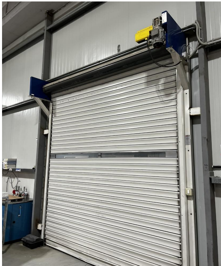
Εικόνα 15: Ρολό εισόδου αποθήκης ισογείου-Κτήριο Α
