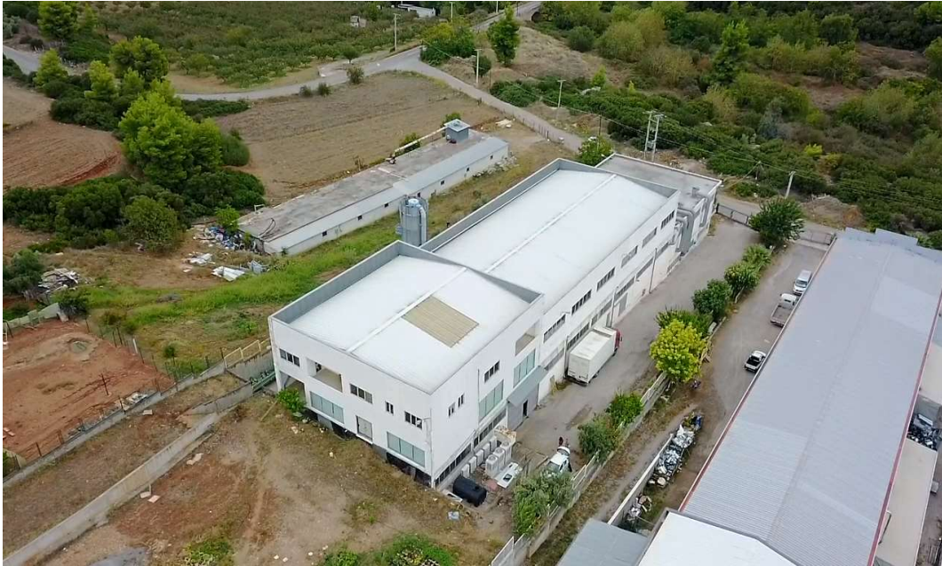
Εικόνα 1 Κτιριακές εγκαταστάσεις της εταιρείας "Χ"
