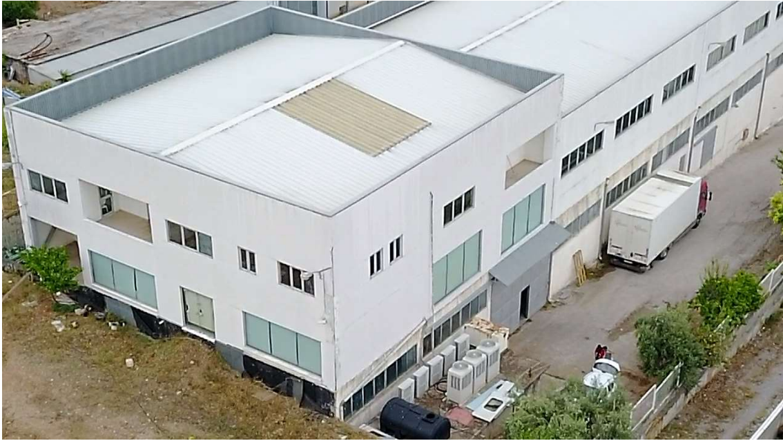
Εικόνα 3 Κτιριακές εγκαταστάσεις της εταιρείας "Χ"
