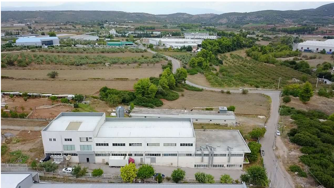
Εικόνα 2 Κτιριακές εγκαταστάσεις της εταιρείας "Χ"
