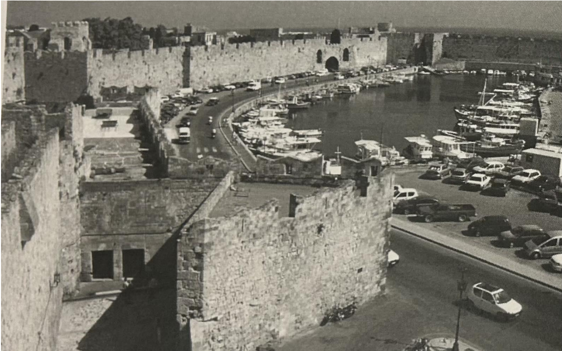
Εικ. 25 Γενική άποψη του θαλάσσιου μετώπου της οχύρωσης
