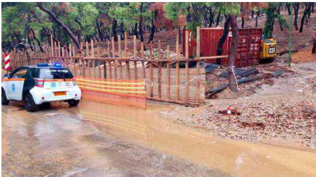
Εικόνα 12: Κατασκευή αντιπλημμυρικών έργων από τον Δήμο Αθηναίων στην περιοχή του Λυκαβηττού
