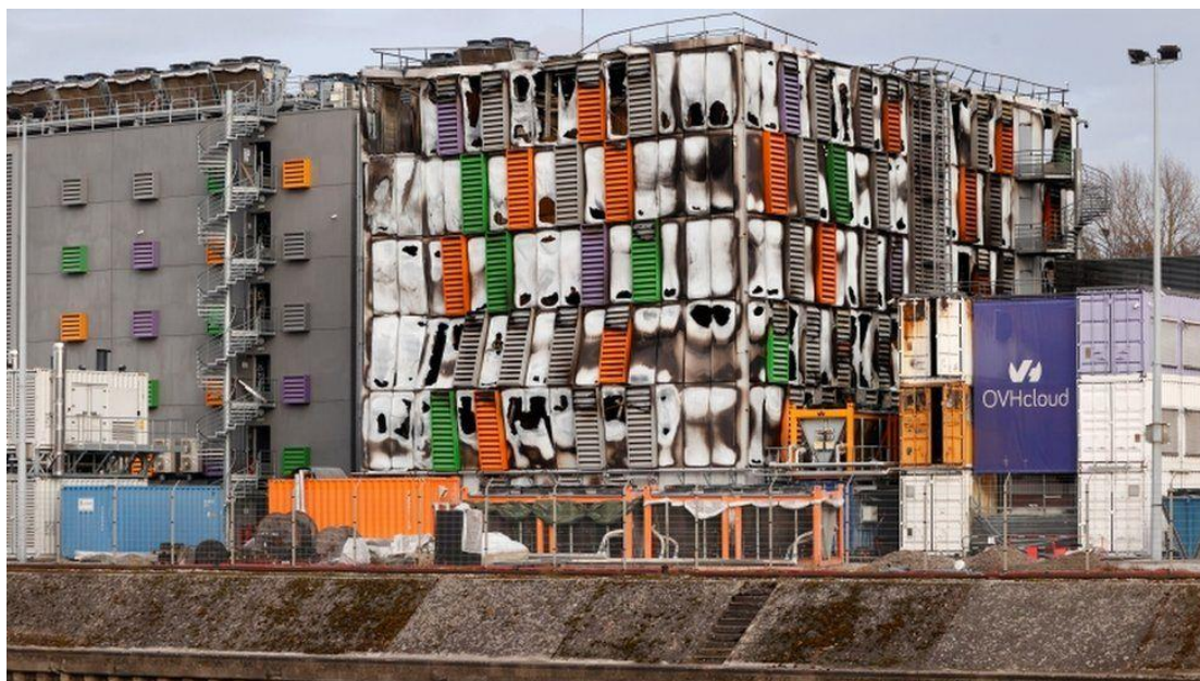
Εικόνα 1 Το datacenter της εταιρίας OVH μετά το πέρας της πυρκαγιάς
