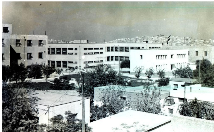
Εικόνα2: Εγκαταστάσεις 700 ΣΕ στο στρατόπεδο «ΣΥΝΤΑΓΜΑΤΑΡΧΗ ΜΑΓΓΙΩΡΟΥ»
