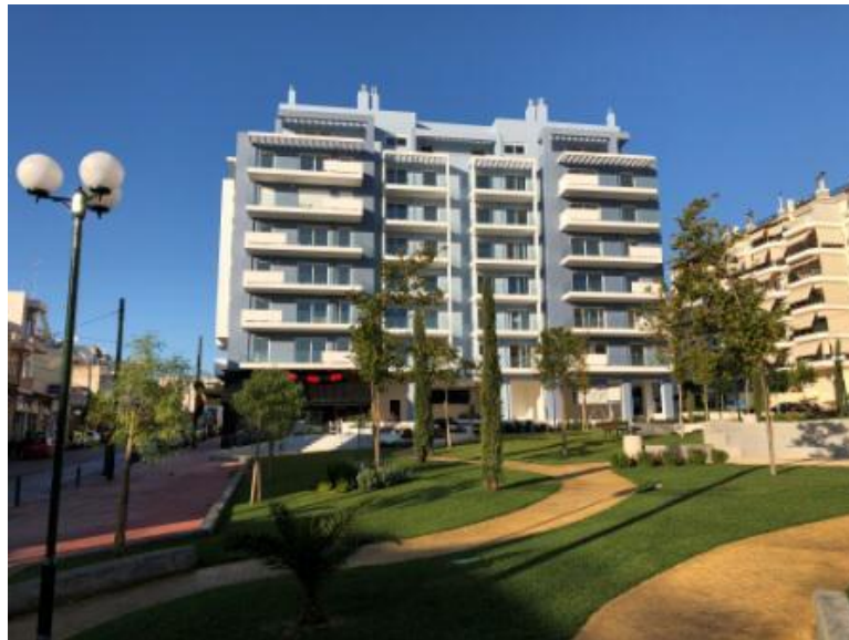
Εικόνα 2.7: Νεόδμητες Πολυκατοικίες Δραπετσώνας
