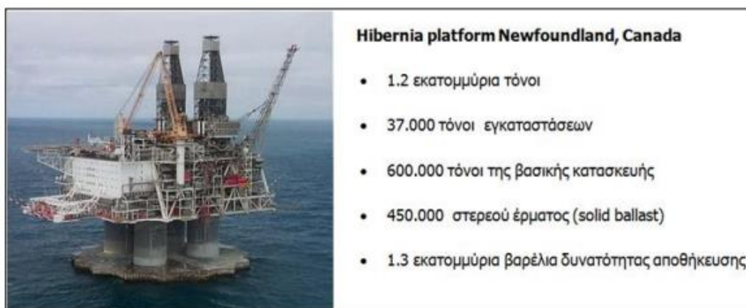
Εικόνα 14: Χαρακτηριστικά μιας πλατφόρμα τεράστιων διαστάσεων στον Καναδά Πηγή: www.offshoretechnology.com/projects/hibernia/
