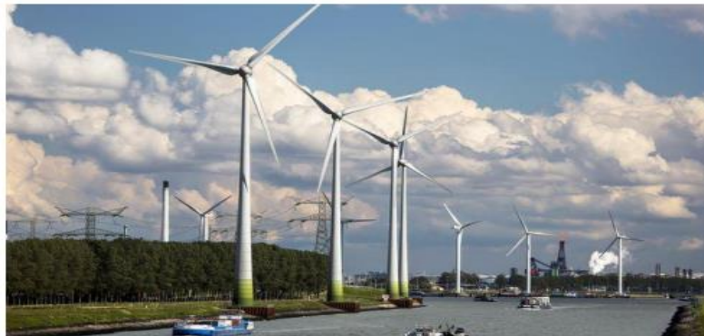
Εικόνα 3: Χρήση ανεμογεννητριών στο λιμάνι του Ρότερνταμ (Πηγή: www.portofrotterdam.com )
