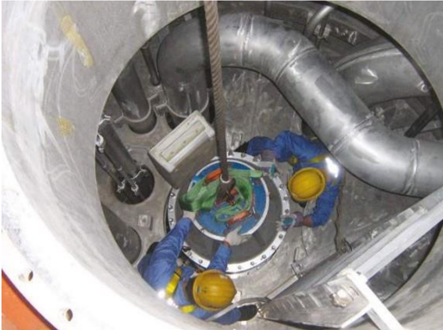
Εικόνα 49. Ανύψωση αντλίας φορτίου από δεξαμενή για επισκευή. Πηγή: SIGTTO/GIIGNL-LNG Shipping at 50 (2014), σελ. 44. lng-shipping-at-50compressed.pdf (sigtto.org)
