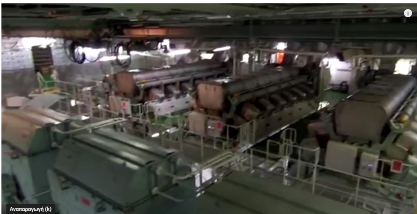
Εικόνα 42. Λεπτομέρεια από μηχανοστάσιο LNG DFDE πλοίου με 4 μηχανές Warchila (3 V12 και 1 6L) Πηγή: Στιγμιότυπο από video LNG TOUR ENGINE ROOM-PROPULSION MOTORS - YouTube
