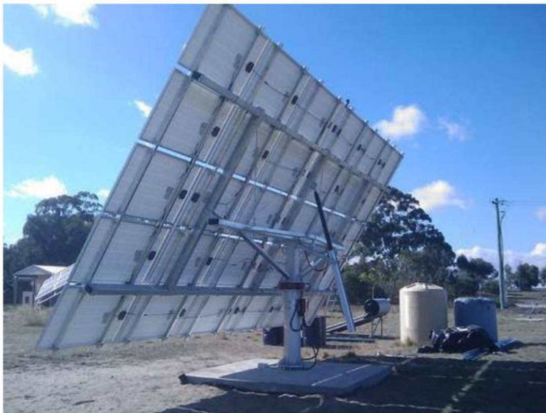
Εικόνα 11: Διάταξη ιχνηλάτησης της πορείας του ήλιου διπλού άξονα
