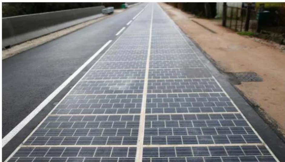
Εικόνα 14: Δρόμος αποτελούμενος από φωτοβολταϊκά (Tourounre, Γαλλία)
