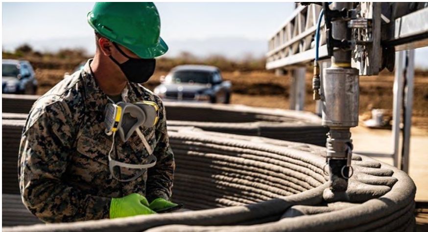
Εικόνα 30: Τριδιάστατη εκτύπωση δομών σκυροδέματος από Αμερικανούς Πεζοναύτες με τον εκτυπωτή Icon Vulcan (Πηγή: Icon, 2021)
