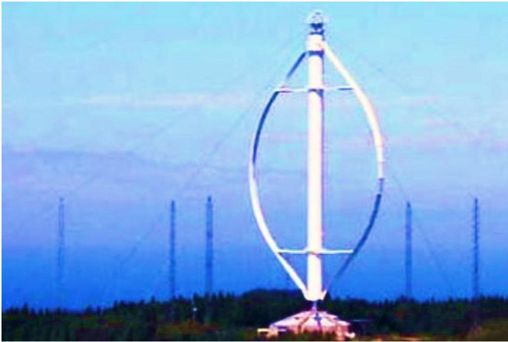
Εικόνα 1.3.Ανεμογεννήτριες με κάθετο άξονα. ΠΗΓΗ: ( https://www.real.gr )
