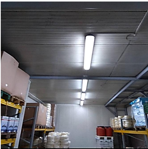
Εικόνα 2. 3. Ψυγεία αποθήκευσης πρώτων υλών
