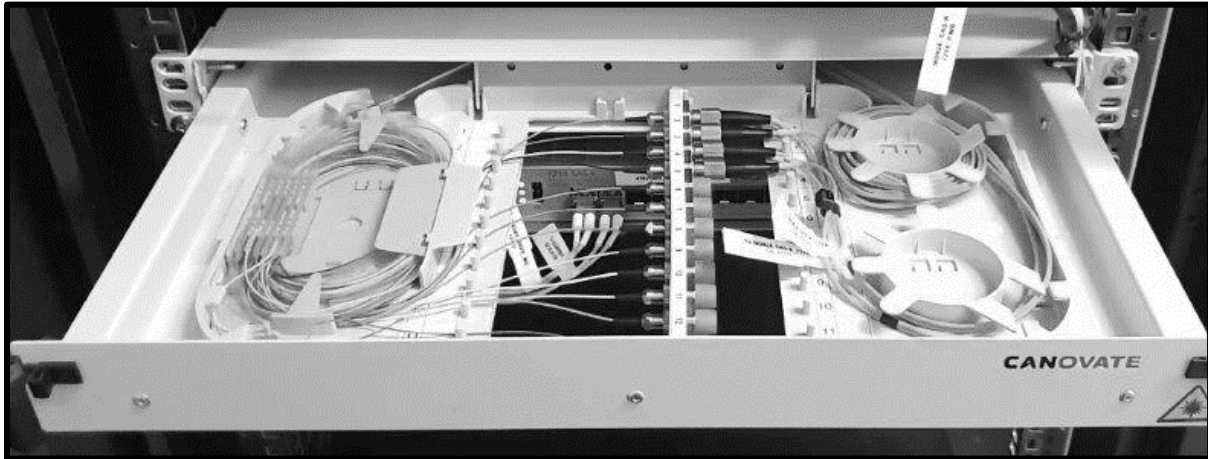
Εικόνα 4.28: Απεικόνιση εγκατάστασης δικτύου οπτικών ινών (SMF)
