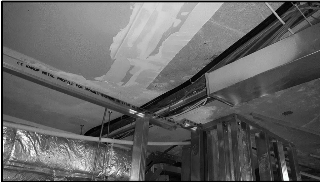
Εικόνα 4.22: Εγκατάσταση 1/2" ομοαξονικού καλωδίου σε οροφοκανάλια κτηρίου υπό κατασκευή
