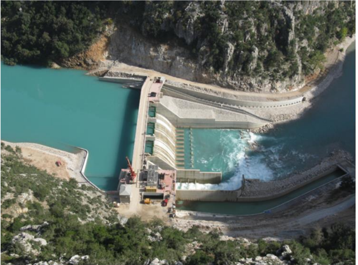
Εικόνα 6: Μικρό Υδροηλεκτρικό Έργο Δαφνοζωνάρας
