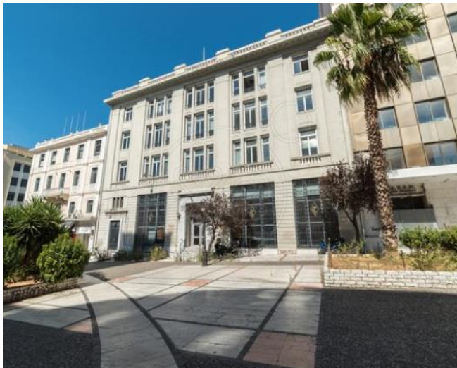
Εικ. 8.1 Νεοκλασικό κτίριο γραφείων με αποθήκες στον Πειραιά
