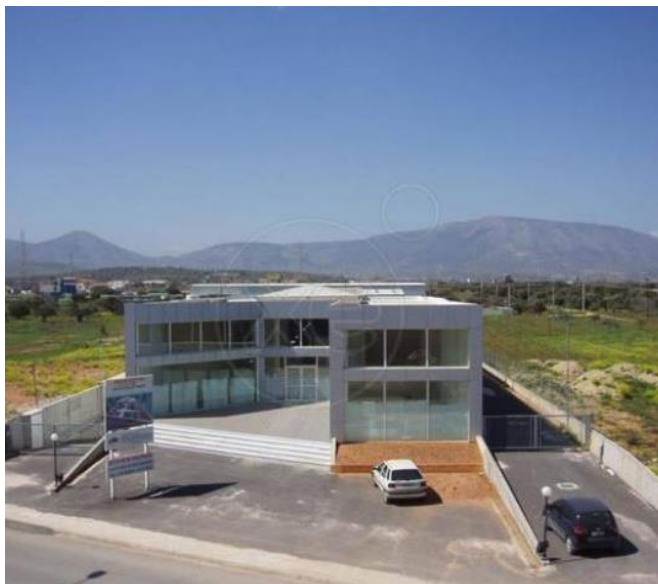
Εικ. 8.3 Κτίριο Γραφείων με αποθήκες στο Μαρκόπουλο Αττικής
