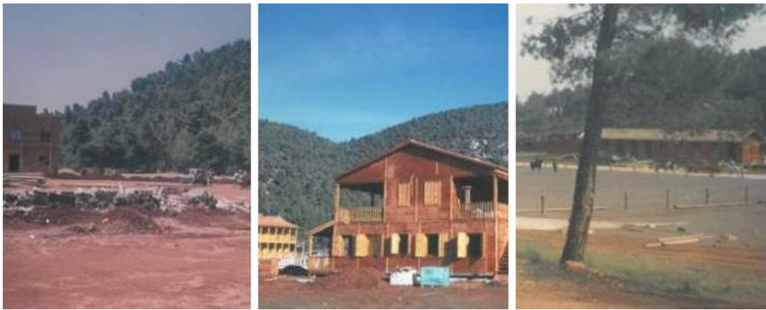
Εικόνα 1. Έτος 2000 : Φωτογραφίες από την έναρξη Εργασιών Οικοδόμησης, υλοποίηση 3.000τ.μ.
