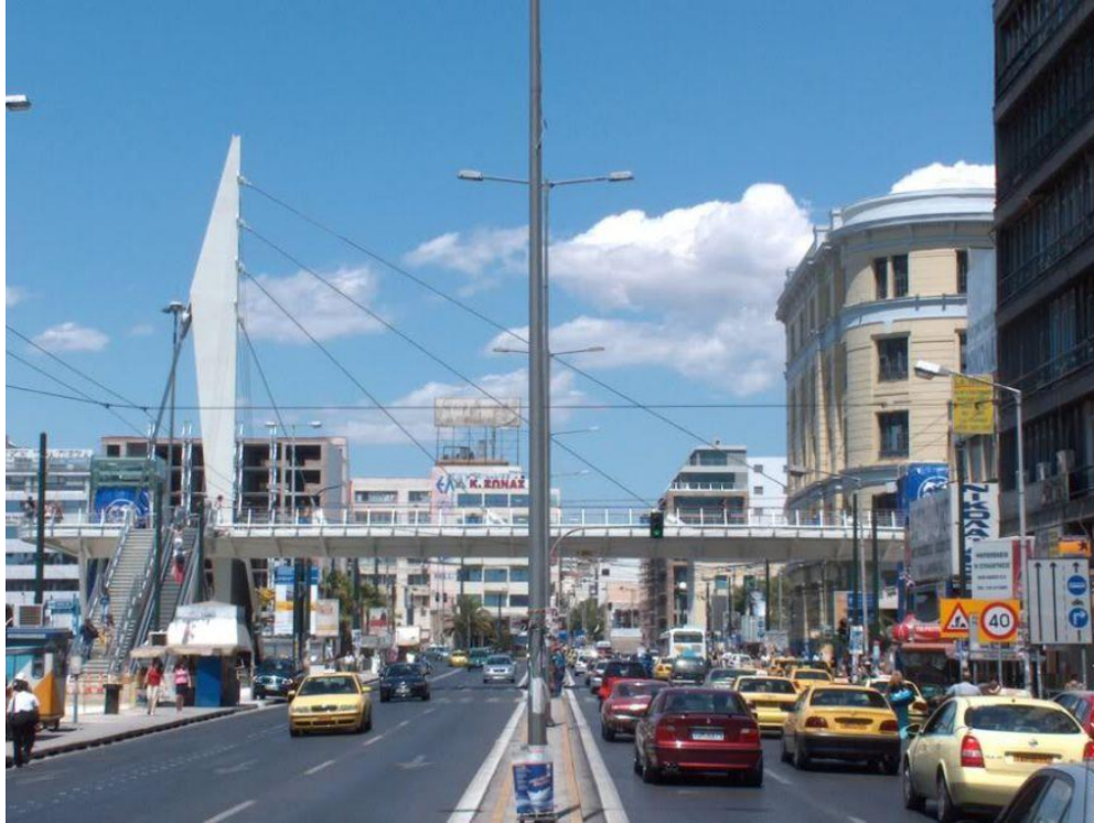
Εικόνα 7: Η καλωδιωτή πεζογέφυρα στο λιμάνι του Πειραιά.
