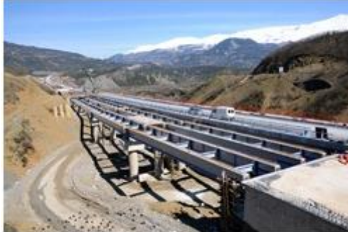
Εικόνα 4: Κατασκευή Σύμμικτου καταστρώματος
