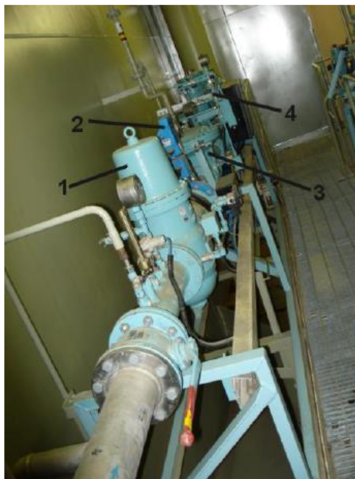
Σχήμα 4.5. Μονάδα όπου πραγματοποιείται η ρύθμιση της ροής του φυσικού αερίου (Skjong et al., 2005).
