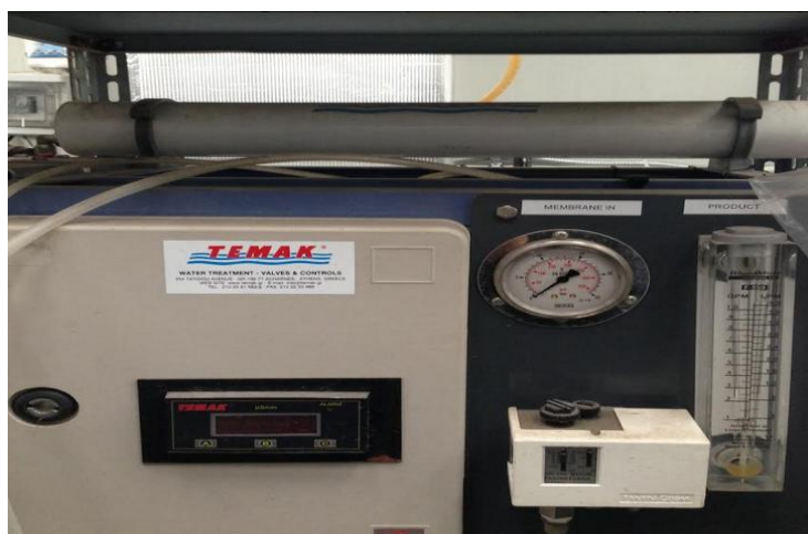
Εικόνα 4.1: Σύστημα επεξεργασίας και καθαρισμού υγρών αποβλήτων κινητήρων
