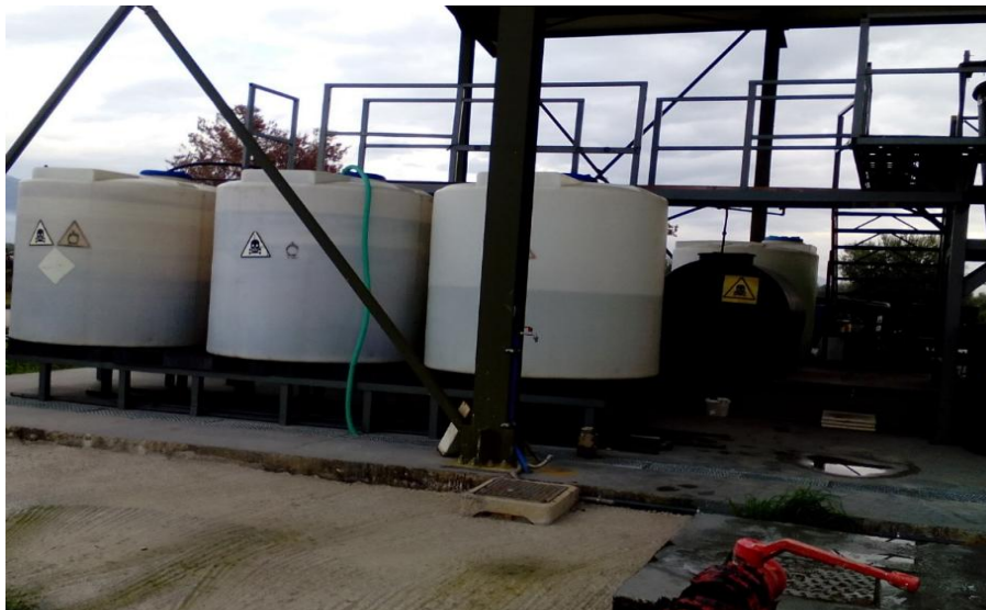
Εικόνα 4.4 : Σύστημα εξουδετέρωσης - καταβύθισης
