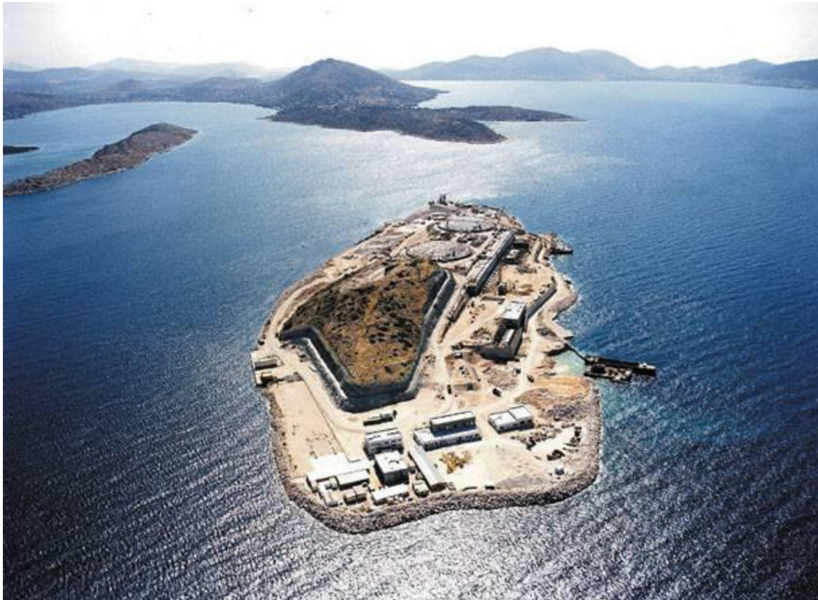
Εικόνα 5.1: Τερματικός Σταθμός Υγροποιημένου Φυσικού Αερίου Ρεβυθούσας
