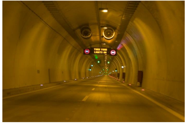
Εικόνα 2 : Εσωτερική Άποψη Σήραγγας
