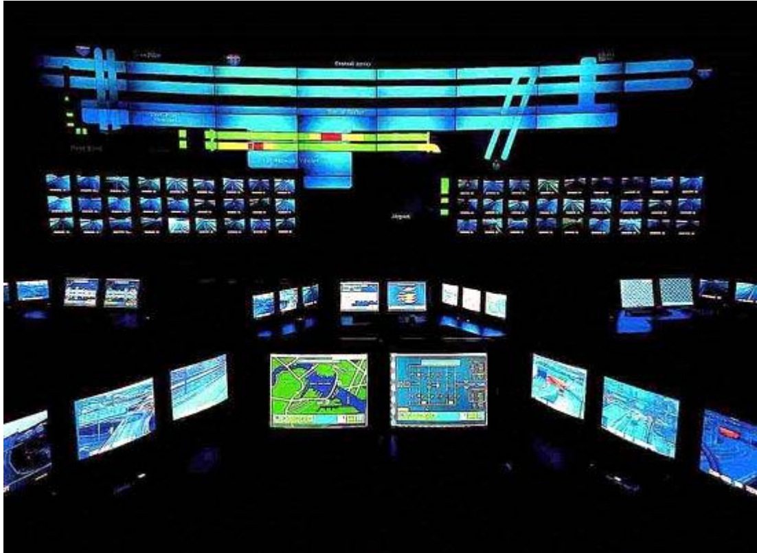
Εικόνα 5 : Ενδεικτική εικόνα Κέντρου Ελέγχου Κυκλοφορίας
