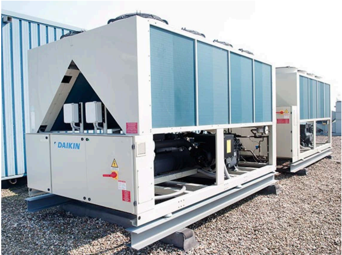
Εικόνα 8 : Αντλίες θερμότητας Αερόψυκτη μονάδα ταυτόχρονης παραγωγής ζεστού – κρύου νερού για τετρασωλήνια συστήματα για εξωτερική εγκατάσταση. Από 33,3 έως 850 kW (κατάλληλες για ξενοδοχεία 12 έως 280 δωματίων)
