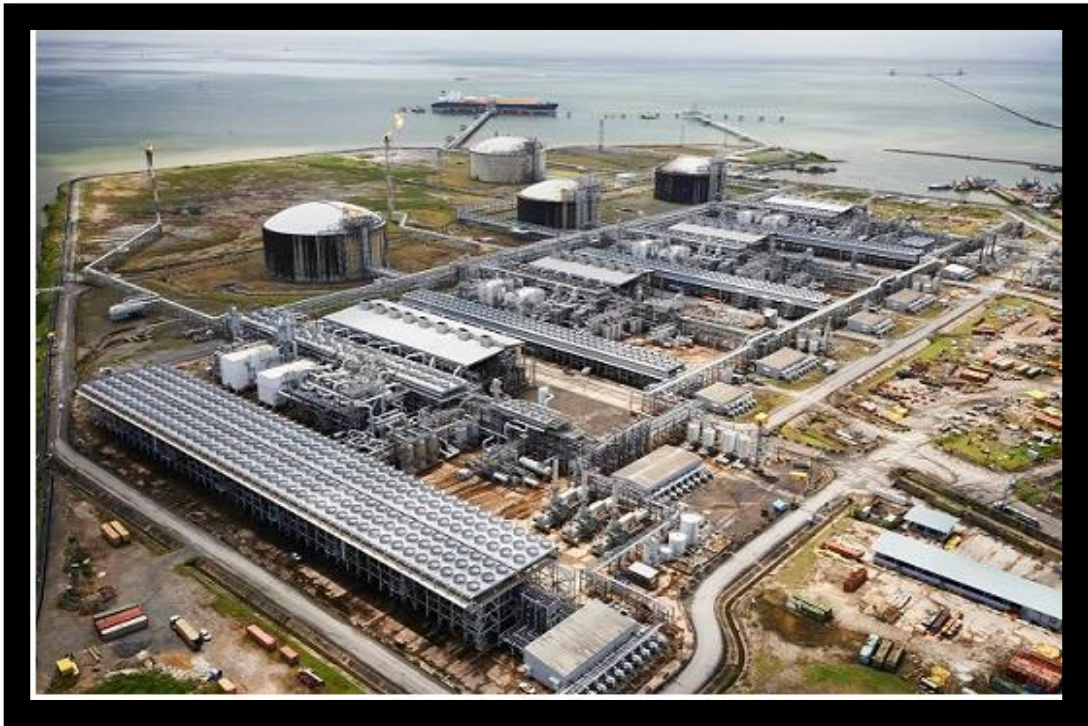
Εικόνα 15: Εγκαταστάσεις LNG Company of Trinidad and Tobago.
