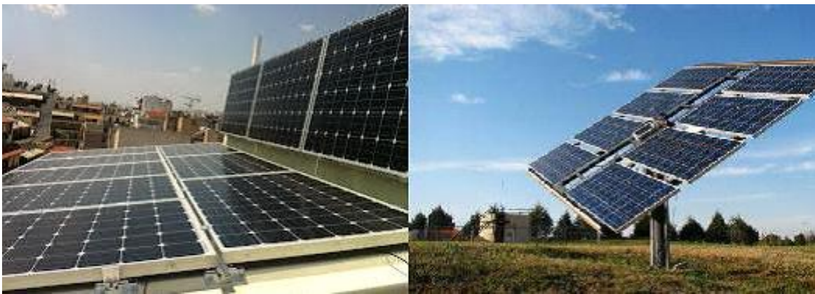
Σχήμα 3.6. Αριστερά: Συστοιχίες Φ/Β πλαισίων σε οριζόντια και κάθετη διάταξη, Δεξιά: Αυτόματο περιστρεφόμενο Φ/Β πλαίσιο. Πηγή: http://www.selasenergy.gr/
