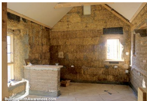
Σχήμα 33 - Εσωτερικό σπιτιού από άχυρο Πηγή : www.buildingwithawareness.com
