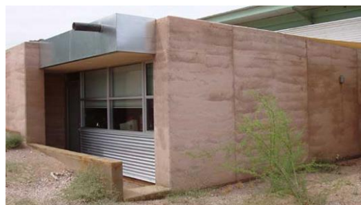
Σχήμα 38 - Κτίσμα από χώμα σε καλούπια Πηγή : www.inspirationgreen.com
