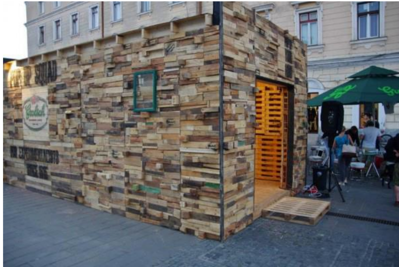
Σχήμα 65 - Κτιριακή κατασκευή από ανακυκλωμένα στελέχη ξύλινων παλετών Πηγή : http://www.recyclart.org/2013/03/wood-art-pavillion-from-recycled-pallets
