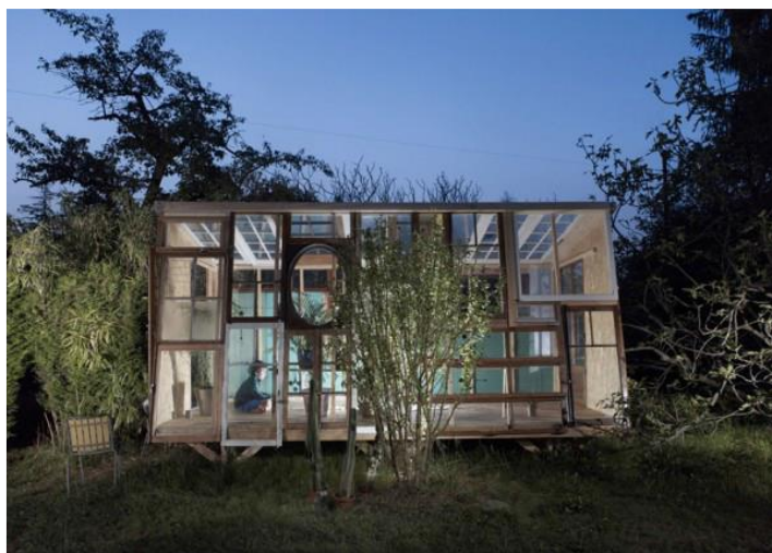
Σχήμα 60 Προκατασκευασμένο κτίριο «La Fabrique» από ανακυκλωμένους υαλοπίνακες
