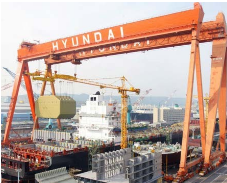
Εικόνα 1.1 Ναυπηγεία εταιρείας Hyundai Heavy Industries, Κορέα
