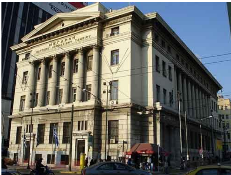
Εικόνα 3. Το κτήριο του Ναυτικού Απομαχικού Ταμείου στον Πειραιά όπως είναι σήμερα
