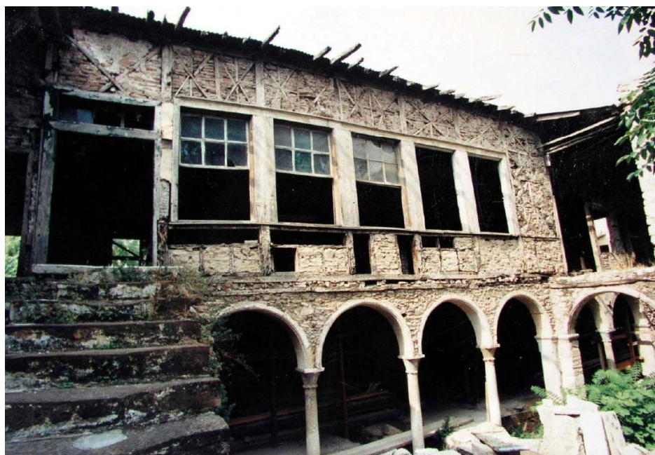
Σχήμα 4.1 . Η βορινή πλευρά του κτηρίου πριν την ανακατασκευή
