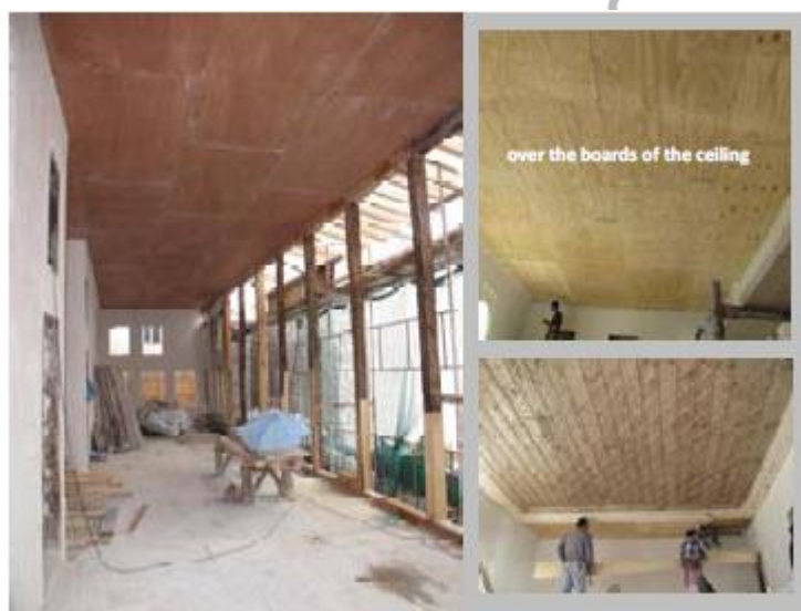
Σχήμα 5.4.4.1.1 . Ανακατασκευή οροφής.
