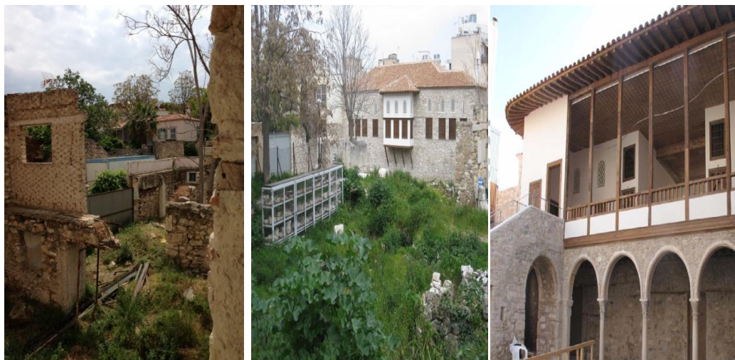
Σχήμα 5.7.1.2 . Ανατολική, νότια και βόρεια πλευρά κτηρίου
