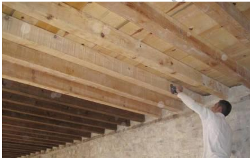
Σχήμα 5.4.4.2.1 . Ανακατασκευή οροφής- πατώματος.
