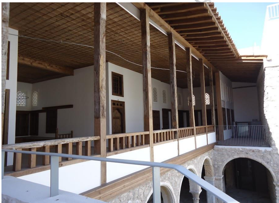
Σχήμα 4.2 . Η βορινή πλευρά του κτηρίου μετά την ανακατασκευή
