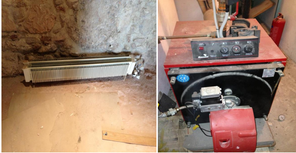
Σχήμα 4.3.1 . Αριστερά ένα από τα θερμαντικά σώματα και δεξιά ο λέβητας
