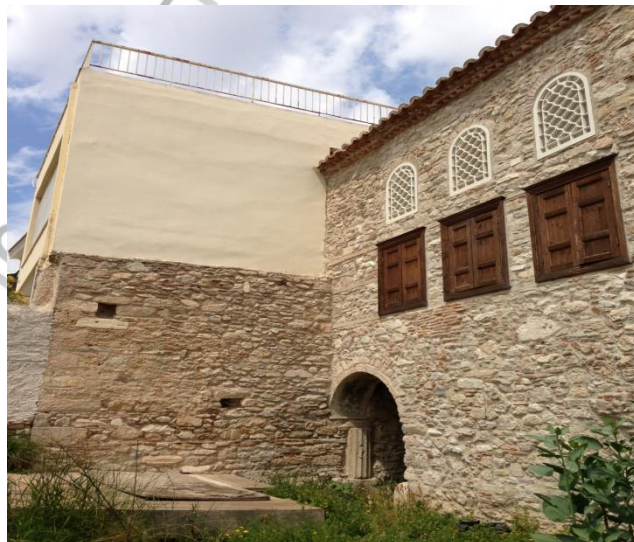
Σχήμα 5.7.1.1 . Δυτική πλευρά κτηρίου
