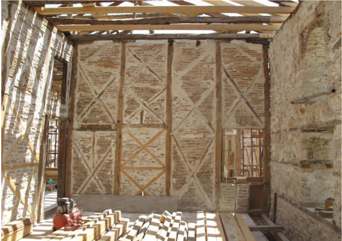
Σχήμα 5.4.3.2 . Μορφή ξυλόπηκτων τοίχων πριν την εφαρμογή των επιχρισμάτων
