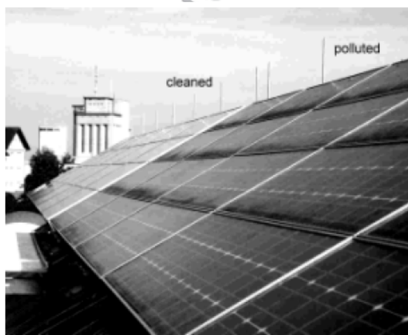
ΕΙΚΟΝΑ 4.9. Πειραματική διάταξη μέτρησης ρύπανσης Φ/Β συστήματος 60kWp εγκατεστημένη στο PV Laboratory , Burgdorf Ελβετίας [14]
