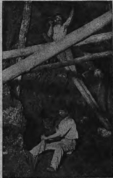
Εἰκ. 1.—Ὑπόγειον λατομεῖον ἐν ἐνεργείᾳ.
