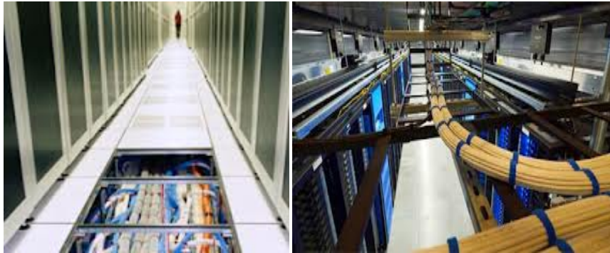
Εικόνα 12 Ενδοδαπέδιος και εναέριος τρόπος καλωδίωσης
