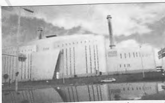
Φώτο 17: Εγκατάσταση καθαρισμού αερίων καύσης στο Ρότερνταμ που βρίσκεται σε κατοικημένη περιοχή .
