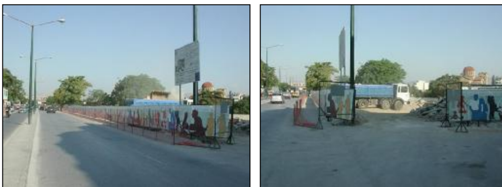
Η οδός Μελιδόνη κατά τη διάρκεια των έργων
