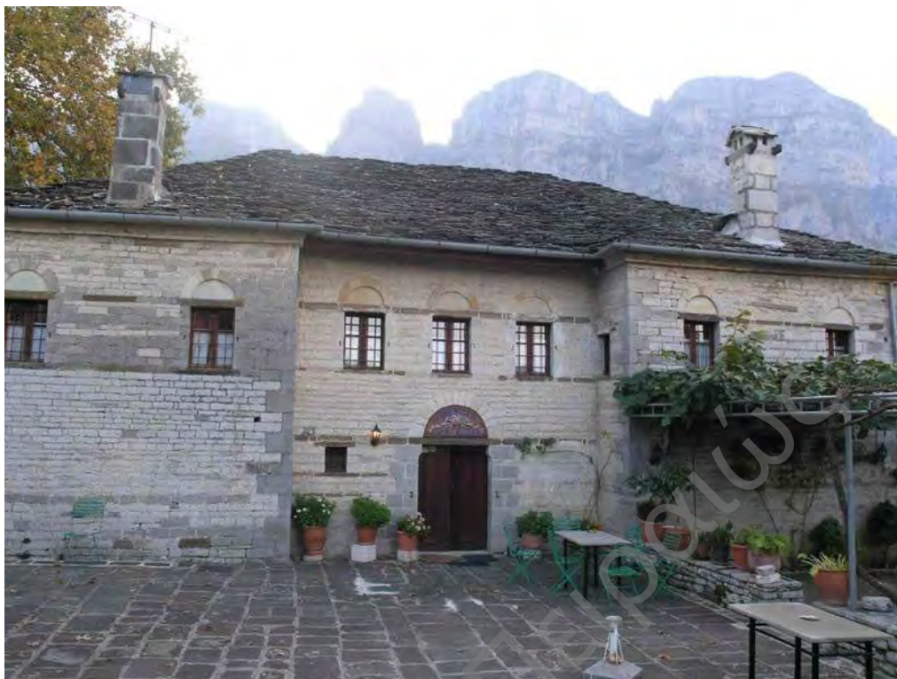
Εικόνα 6 Κτίριο παραδοσιακής αρχιτεκτονικής στην περιοχή του Ζαγορίου, όπου είναι εμφανής η χρήση της τοπικής πέτρας στα κατακόρυφα δομικά στοιχεία και στην επικάλυψη της στέγης
