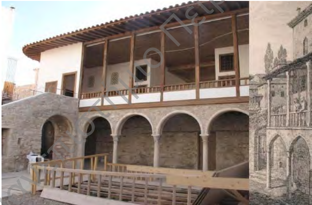
Εικόνα 15 Το Αρχοντικό των Μπενιζέλων μετά την αποκατάστασή του
