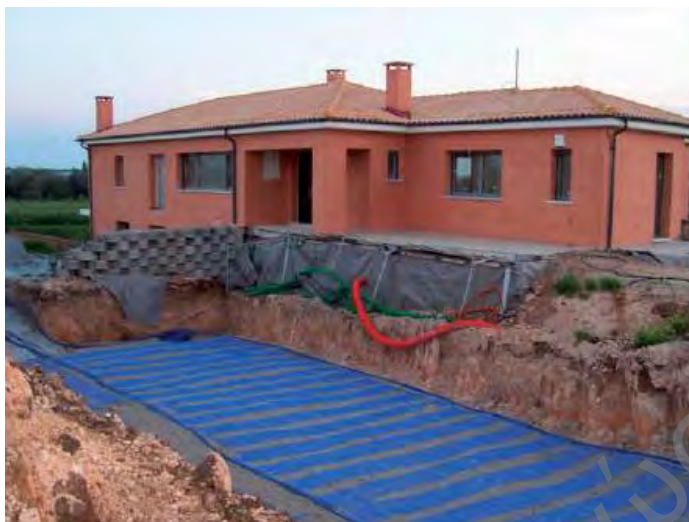
Εικόνα 13 Αναδρομική εγκατάσταση συστήματος γεωθερμικής αντλίας θερμότητας σε μονοκατοικία
