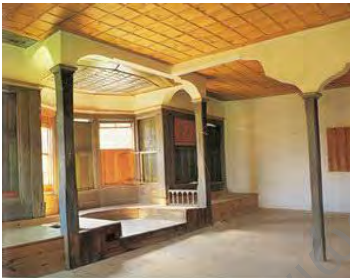
Εικόνα 4 Εσωτερική άποψη παραδοσιακού σπιτιού στο Ζαγόρι, όπου είναι εμφανή τα δάπεδα, οι οροφές και οι κατακόρυφοι στύλοι από ξύλο
