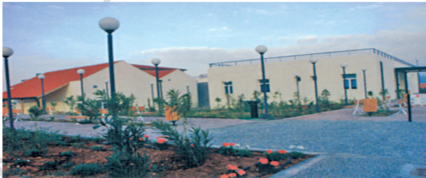
ΕΙΚΟΝΑ 4: Εξωτερική άποψη του Αστικού Κέντρου Υγείας Καλυβίων
