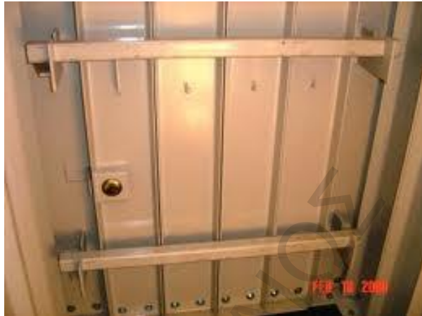
Εικόνα 14: Θωρακισμένη πόρτα του Citadel
