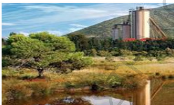
Εργοστάσιο Μηλακίου ΑΓΕΤ Ηρακλής
