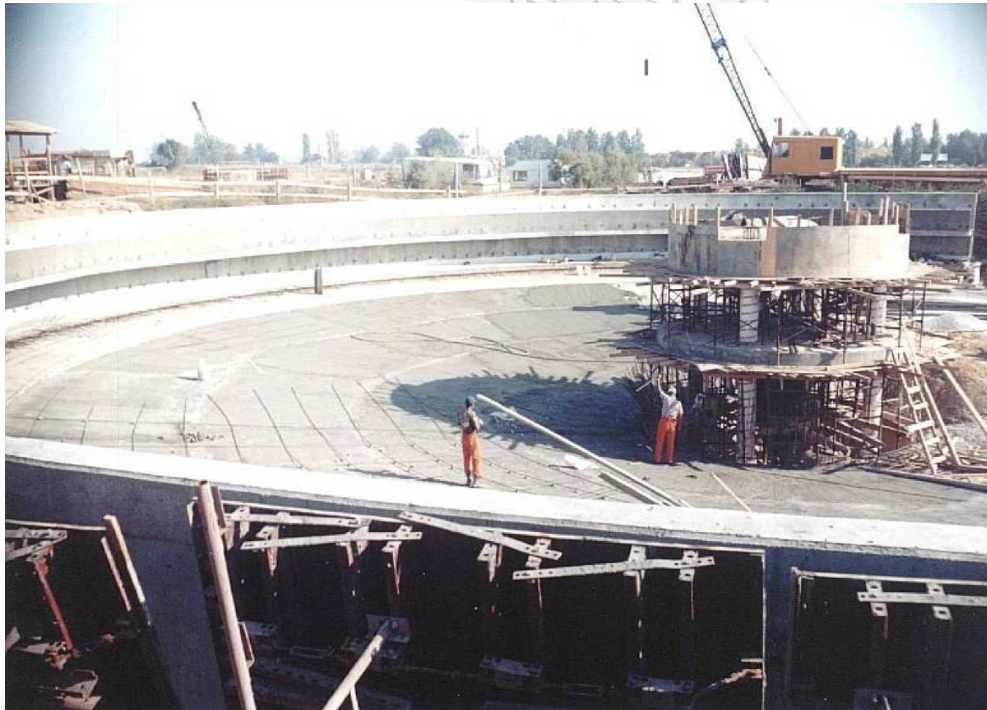
Σχήμα 4.11: Κώνος ιλύος δεξαμενής καθίζησης στη φάση κατασκευής
