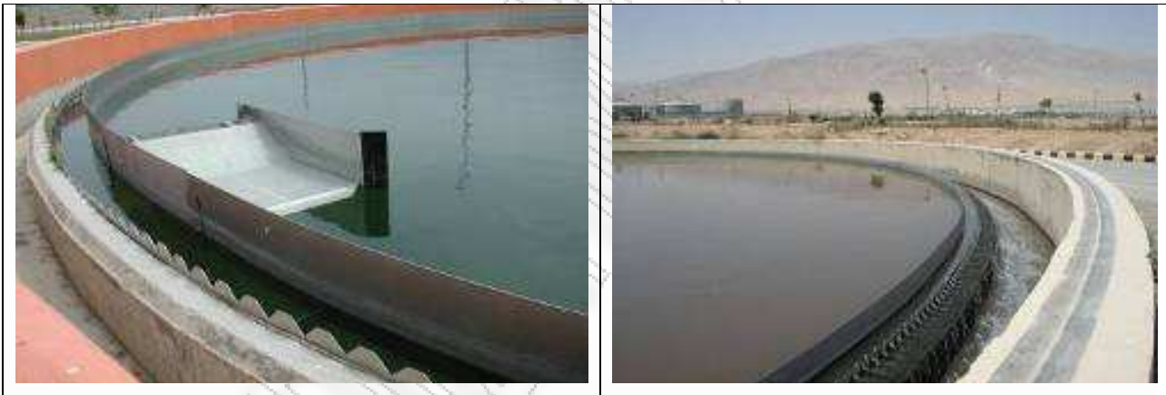
Εικόνα 4.9: Δεξαμενές καθίζησης (Λεπτομέρεια οδοντωτού υπερχειλιστή)
