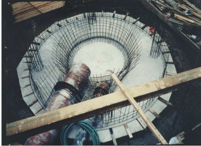
Εικόνα 4.10: Κώνος ύλος δεξαμενής καθίζησης στη φάση κατασκευής
