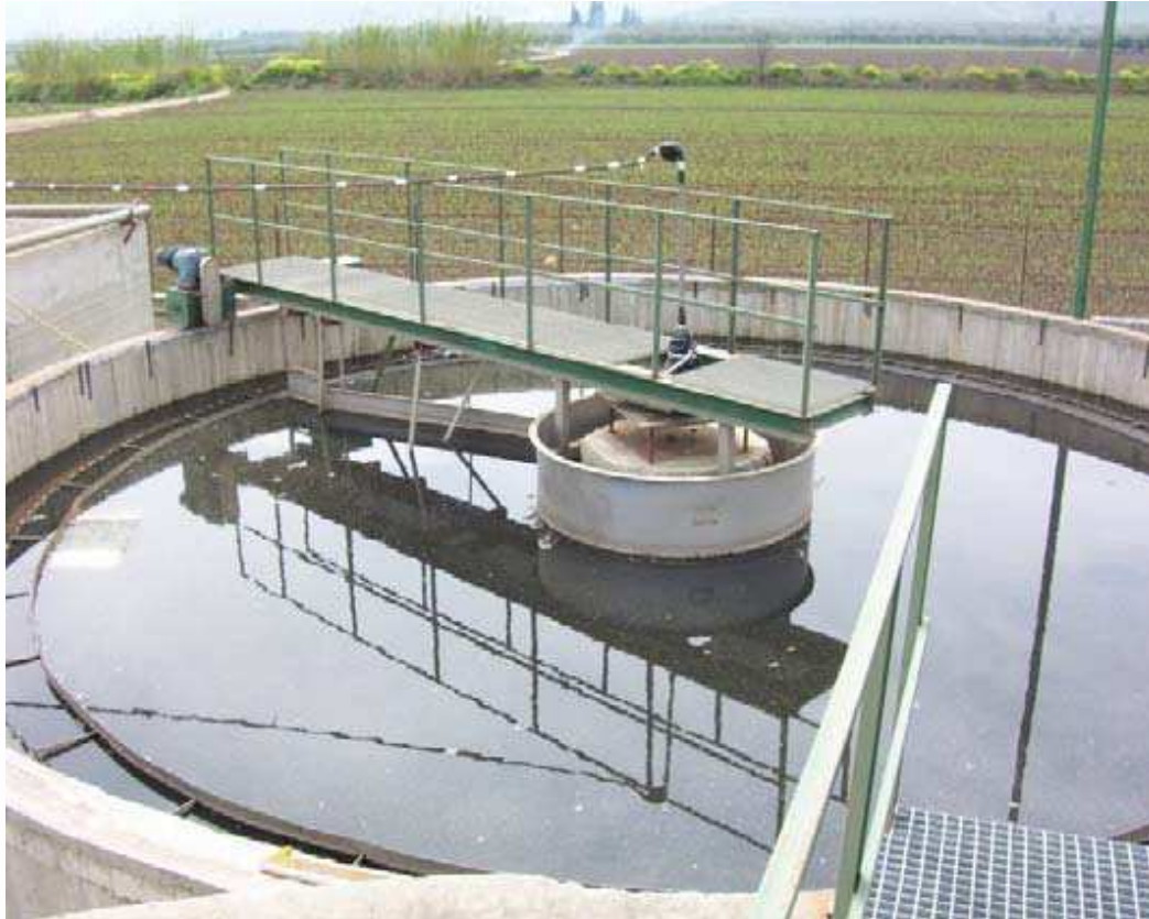
Εικόνα 4.4: Κυκλική Δεξαμενή Καθίζησης
