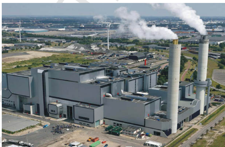
Μονάδα Αποτέφρωσης Amsterdam
