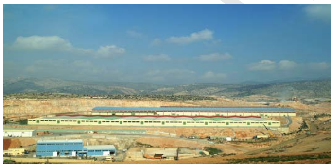
Εργοστάσιο M.B.E. – ΕΜΑΚ Άνω Λιοσίων
