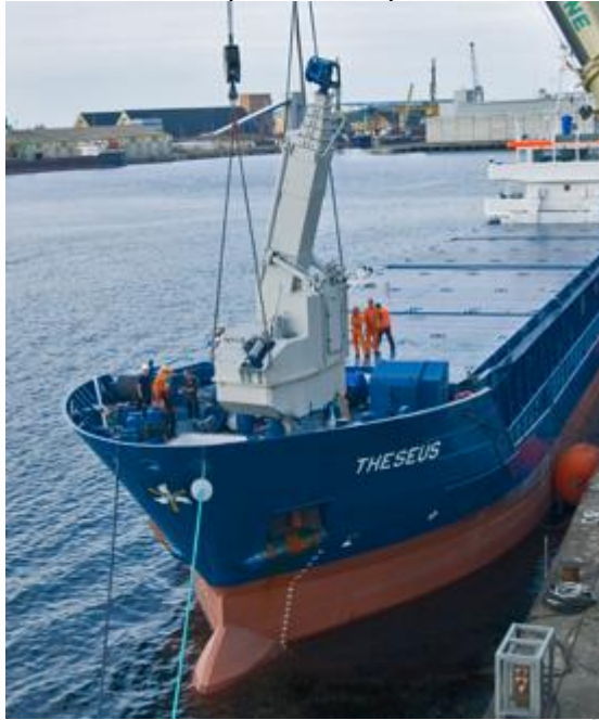
Εικόνα 3.9: Η εγκατάσταση στο πλοίο
