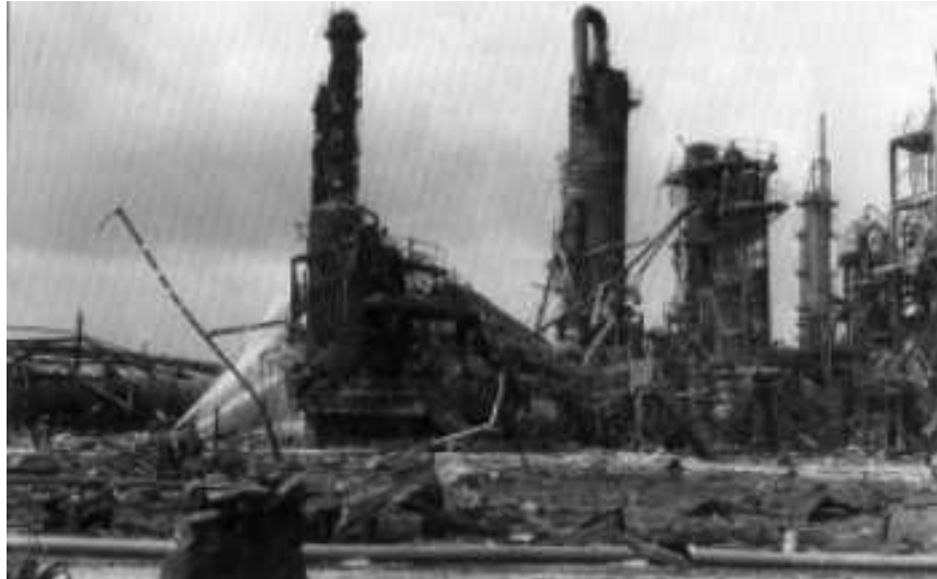
Εικόνα 3. Οι εγκαταστάσεις της Icmesa στο SEVEZO μετά την έκρηξη (από πηγή [5])
