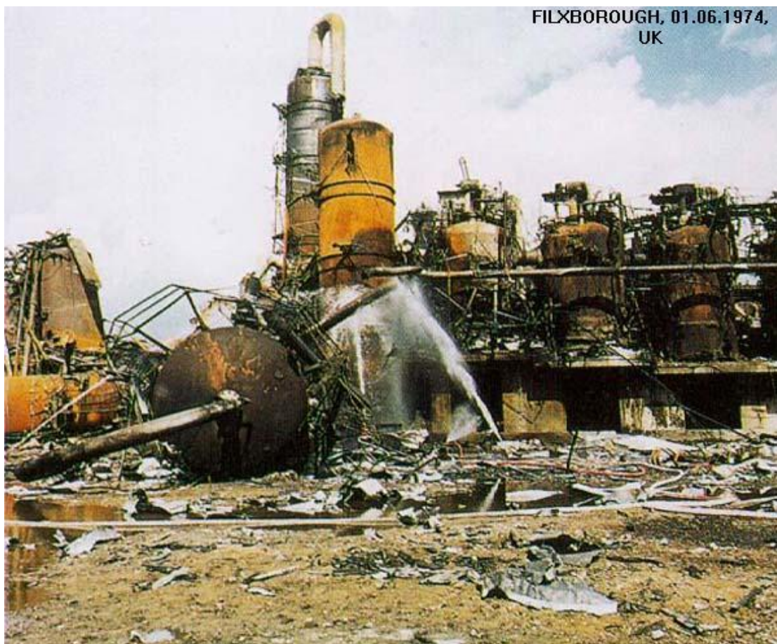
Εικόνα 2. Η χημική εγκατάσταση της Nypro Ltd στο Flixborough μετά την έκρηξη (από πηγή [4])
