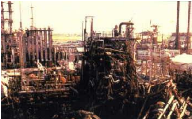
Εικόνα 4. Άποψη των εγκαταστάσεων της Icmesa στο SEVEZO μετά την έκρηξη (από πηγή [5])
