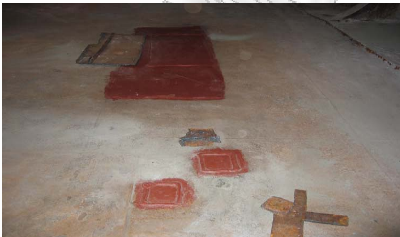
Εικόνα Γ15: Tank top of double bottom no.2. not watertight (found with holes)
