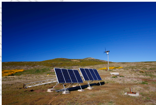
Εικόνα 3.1: Ένα υβριδικό σύστημα παραγωγής ενέργειας με φωτοβολταϊκά και ανεμογεννήτρια
