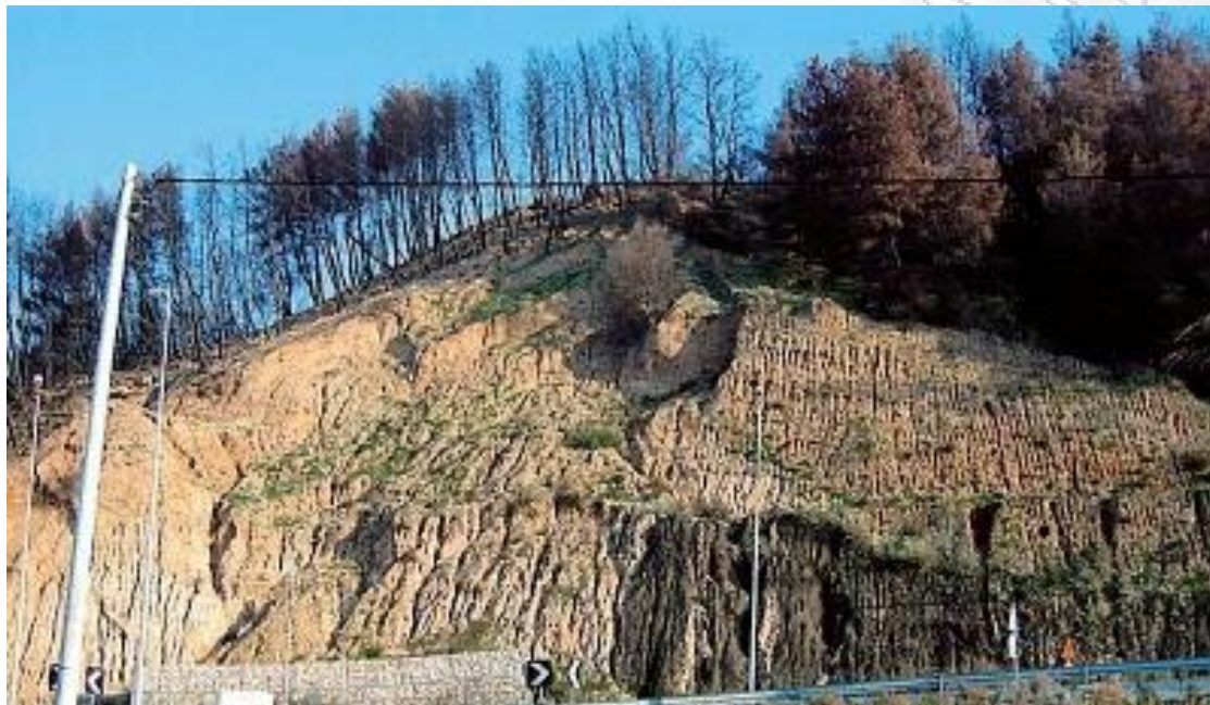
Σχήμα 3.24: Εικόνα εδάφους που έχει διαβρωθεί.
