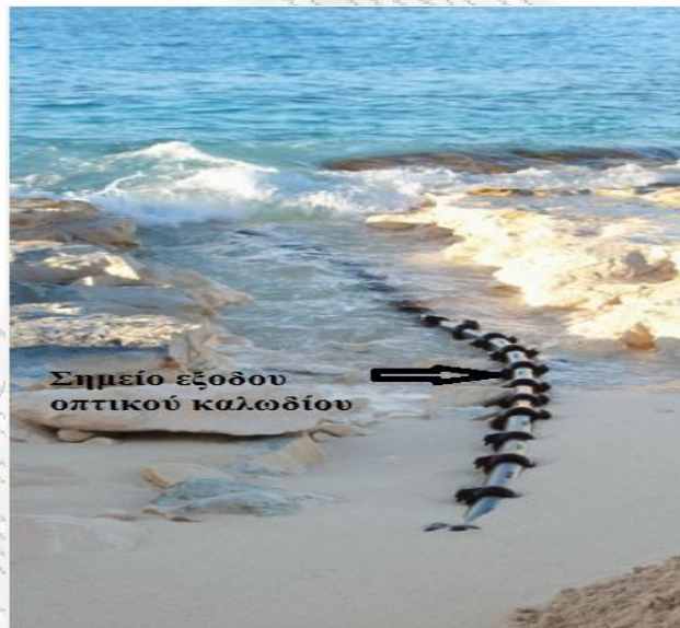
Εικόνα 5. 3 Έξοδος καλωδίου από τη θάλασσα
