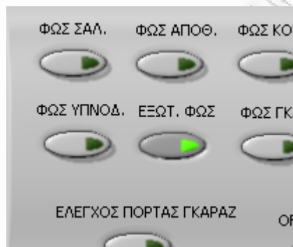
Εικόνα 28. Διακόπτης ενεργοποίησης και απενεργοποίησης εξωτερικού φωτισμού.
