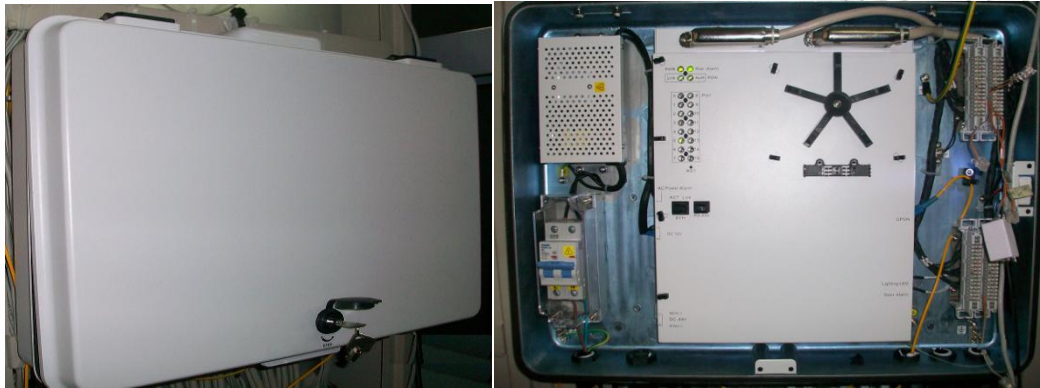
Εικόνα 2. Συσκευή τερματισμού οπτικής ίνας – FTTB [28]
