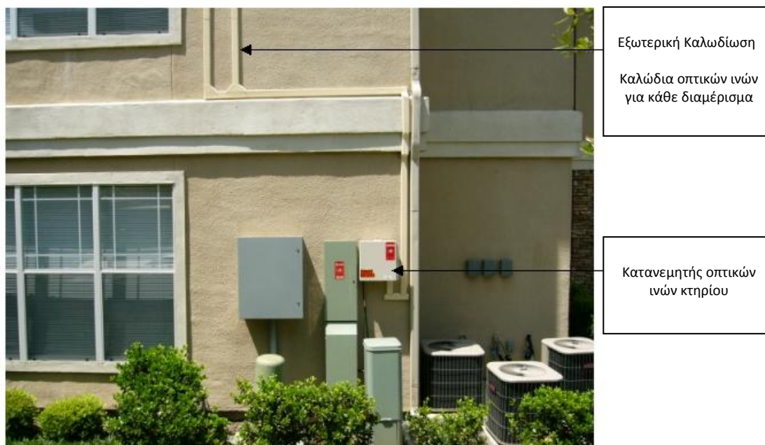
Εικόνα 3. Μετατροπή FTTB σε FTTN με τη κατασκευή οπτικής “εσωτερικής” καλωδίωσης [34]
